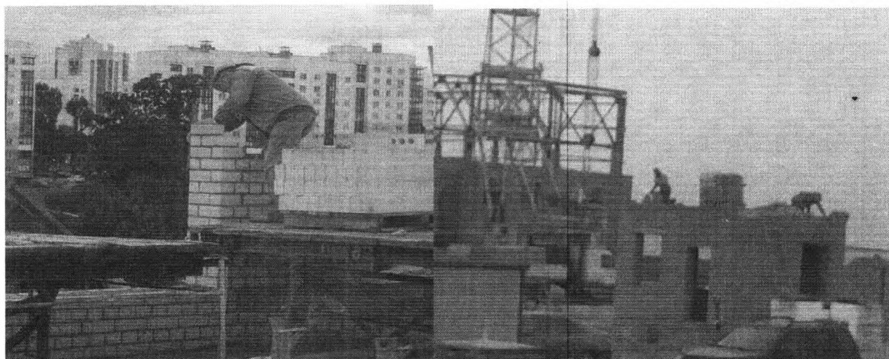
Работающие, выполняющие кладку, находятся на высоте более 1,3 м и расстоянии менее 2 м от границы неогражденного перепада по высоте, без применения средств индивидуальной защиты от падения с высоты
